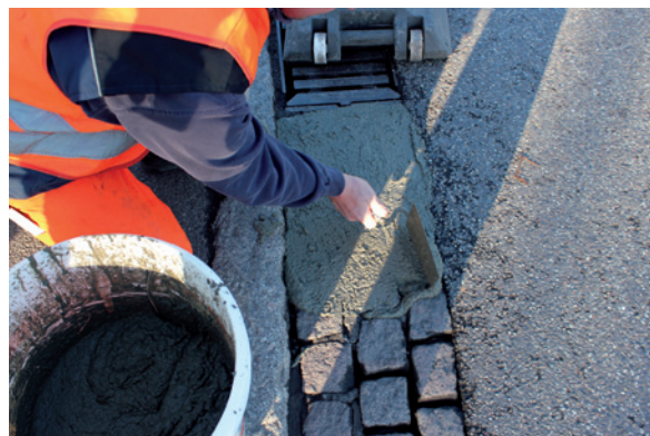
Spárování dlažebních kostek s MasterEmaco T 1200PG při teplotách do -5 °C.
