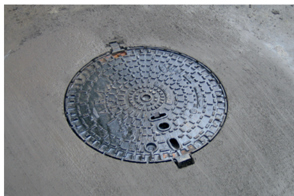
Usazení rámu kanálu s MasterEmaco T 1100TIX při teplotách do -5 °C.
