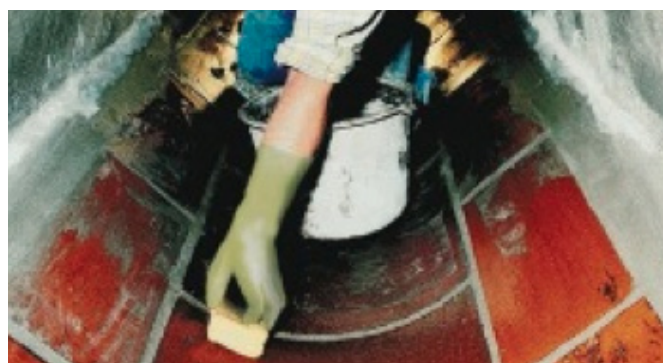
Vyplnění spár maltou PCI Polyfix® plus.
