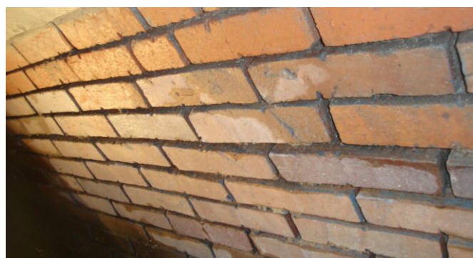
Vyčištěné spáry ve zdivu.
