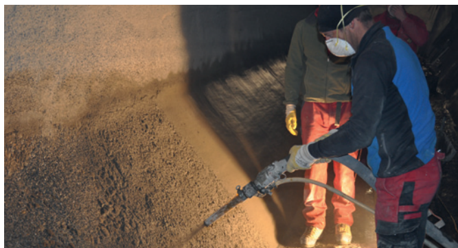
Celoplošná strojní reprofilace maltou MasterEmaco S 5400.
