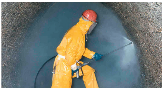
Příprava poškozeného povrchu tryskáním vysokotlakým vodním paprskem.
