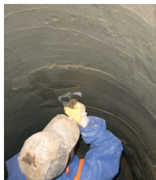
Lokální ruční oprava.
