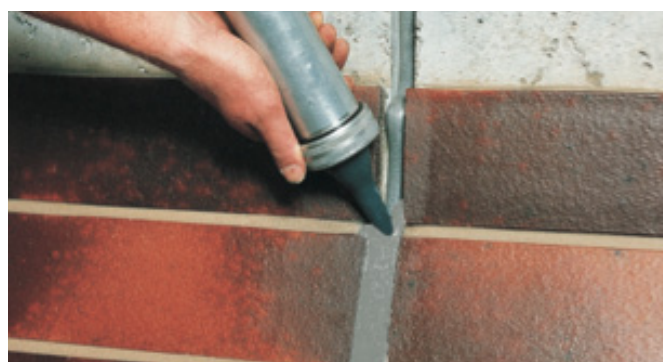
Vyplnění spojovacích a dilatačních spár.
