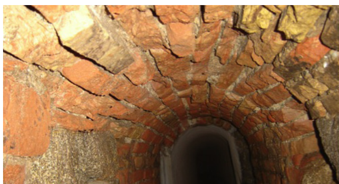
Předúprava kabřincového zdiva tryskáním vysokotlakým vodním paprskem.
