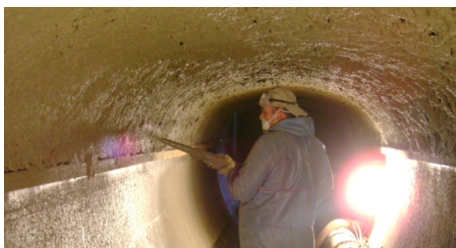
Celoplošná strojní reprofilace maltou MasterEmaco S 5400.
